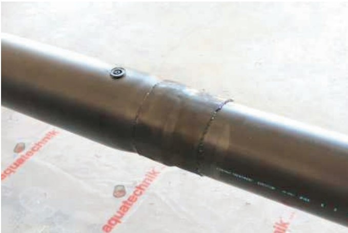
18 - Il giunto a doppia tenuta garantisce la massima tenuta e il massimo isolamento, prevenendo ogni rischio di infiltrazione.
