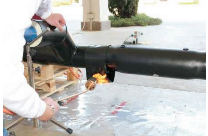
17 - Procedere con la saldatura, scaldando la fascia tramite l'uso del cannello in tutte le direzioni fino a completo restringimento. Ripetere l'operazione per entrambe le fasce.
