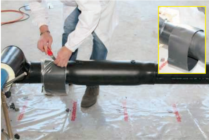
16 - Dopo aver effettuato la pulizia con il liquido pulitore 50330, togliere la pellicola di confezionamento dalla fascia termorestringente e posizionarla sopra la saldatura del tubo guaina casing avendo cura che la linea mediana delle fasce corrisponda alla linea di saldatura.
